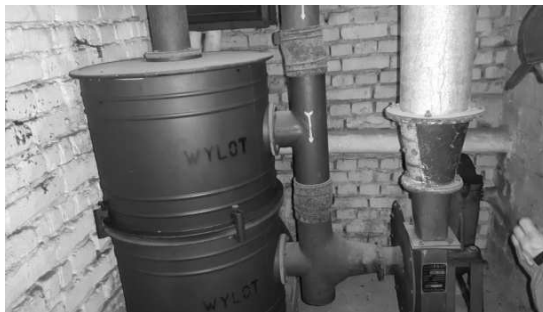
Foto 7. Przeszarżały agregat filtro-wentylacyjny RM - 150. Mój przewodnik nie potrafił określić czy kiedykolwiek filtry były wymieniane. Z pewnością stwierdził, że minimum od 14 lat nie były wymieniane (foto: Adrian Gawor)
