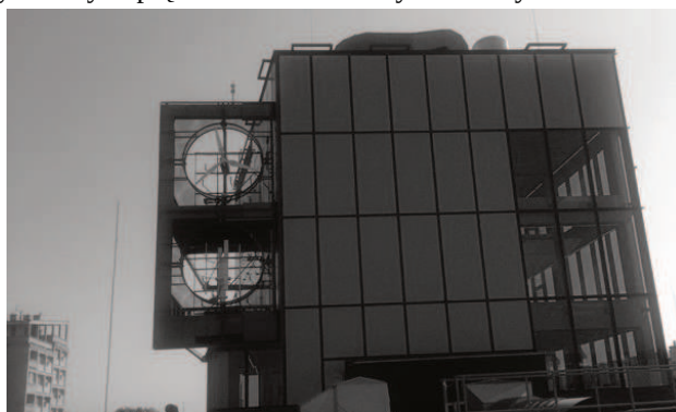
Rysunek 1. Konfiguracja turbin przy elewacji budynku CE (u góry turbina o osi poziomej, na dole turbina o osi pionowej).
